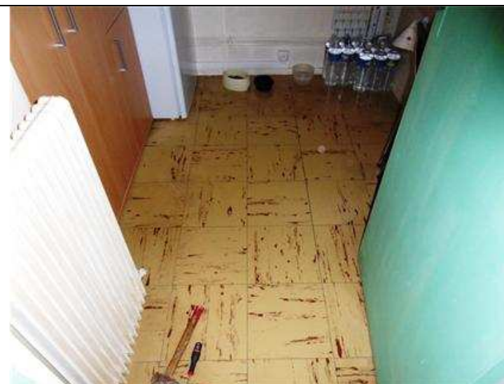
004 - Appartement - Cuisine LOT 0001 PH2 : Dalle, colle, ragréage PRE002
